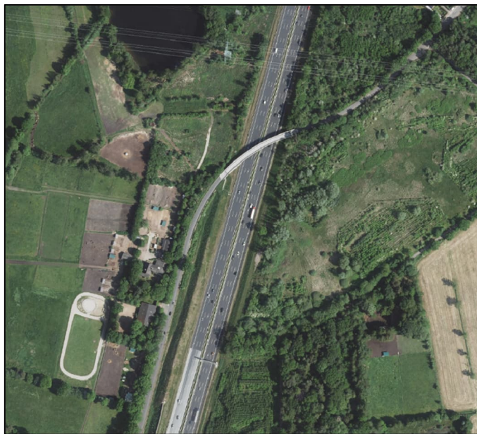
Luftbildaufnahme Brücke Ulzburger Landstraße über BAB 7 [Quelle: © GeoBasis-DE/LVermGeo SH, BKG]
