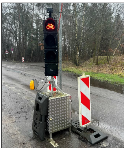
Abbildung 5 - Lichtsignalanlage für Radverkehr im Nordwesten zur Querung der Fahrbahn nach Norden [Quelle: Eigene Darstellung]
